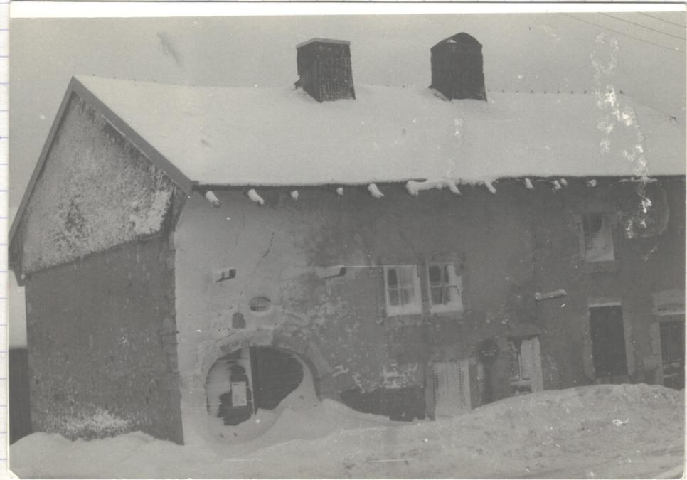
Les maçons vont d'abord réaliser un très bon crépiasse, avant de démonter la voûte déformée, couler un mur intérieur, au fond de l'étable afin de consolider les fondations sous cette porte.
