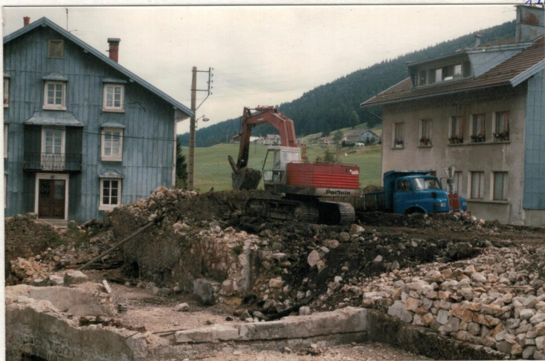
En-dessous, Gidoin est revenu <sup>aussi!</sup>. Le sous-sol de la scierie a été presque totalement vidé. Il reste à remonter la plus grosse pierre : c'est le socle sur lequel étaient fixés les volants des deux chassis = scies verticales actionnées par la turbine. À gauche, on distingue bien la dalle armée de poutres métalliques qui couvre le canal de fuite, à l'aval de la chambre d'eau, et en amont du petit pont.
