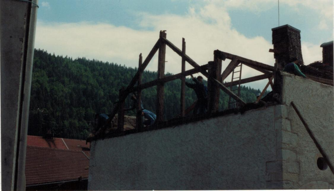
Ce-dessous : l'avant toit côté rivière a au moins 2m de largeur, il est soutenu par une pente extérieure volante. Quand nous avons tronqué les supports de cette pente, l'ensemble des vieux chevrons a basculé, de façon à recouvrir une grande partie du moulin ...
