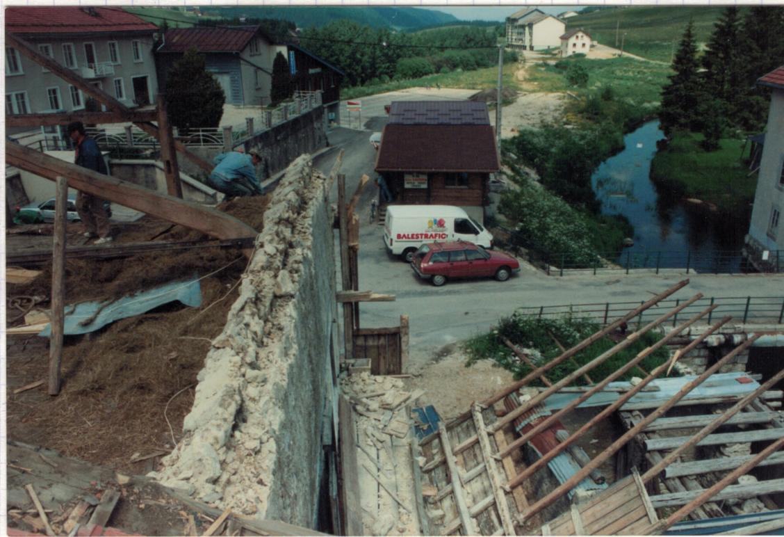
Je me rappelle, en observant ces photos que nous avions fixé un tendeur et un tirant métallique dans la ferme endommagée.
